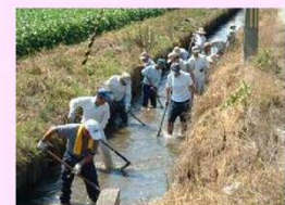
水路の泥上げ
