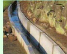
コンクリート水路の更新
