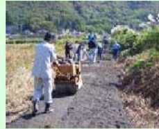
未舗装農道の舗装
