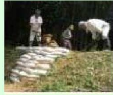
漏水箇所の補修
