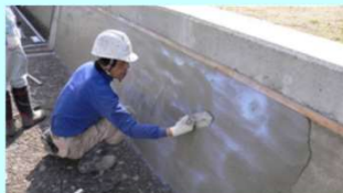
老朽化した水路壁のコーティング
