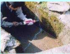
水路のひび割れ補修
