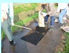
農道の部分補修
