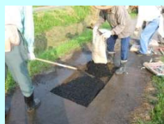
農道の部分補修
