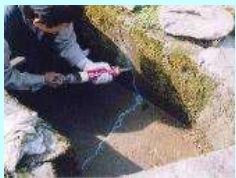
水路のひび割れ補修
