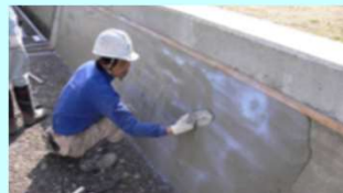
老朽化した水路壁のコーティング
