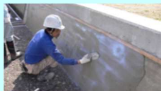
老朽化した水路壁のコーティング
