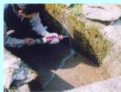
水路のひび割れ補修
