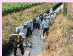
水路の泥上げ
