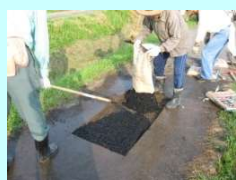
農道の部分補修
