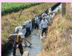
水路の泥上げ
