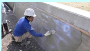
老朽化した水路壁のコーティング
