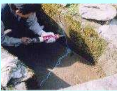
水路のひび割れ補修
